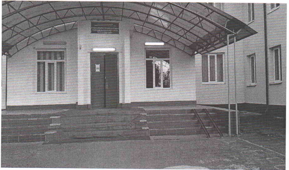
ВХОД В ЗДАНИЕ
